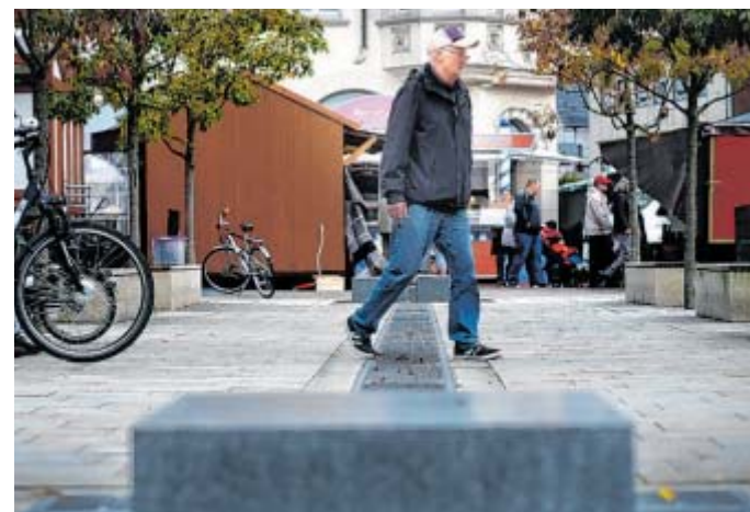
Berliner Platz: Ein Fußgänger überquert das Wasserband. FOTO: FRÜCHT
